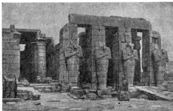
104. Рамессеум. Общий вид второго двора с юго-западной и северо-западной сторон
