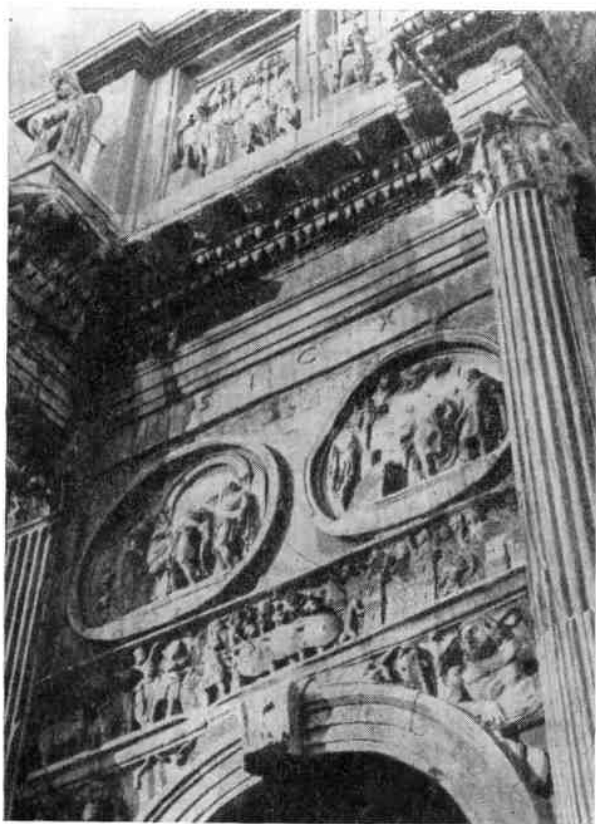
145. Рим. Арка Константина, 315 г. н. э. Фрагмент фасада
