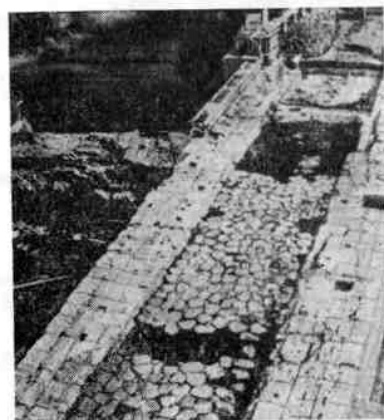
162. Рим. Мост Элия, 134 г. н. э. Вид моста на гравюре Пиранези; вымостка античной дороги близ моста Элия
