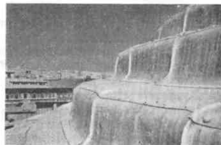
50. Пантеон. Покрытие ступенчатой части купола
