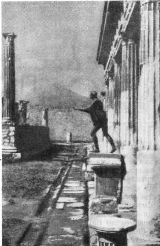
21. Помпеи. Храм Аполлона. I в. до н. э. Общий вид
