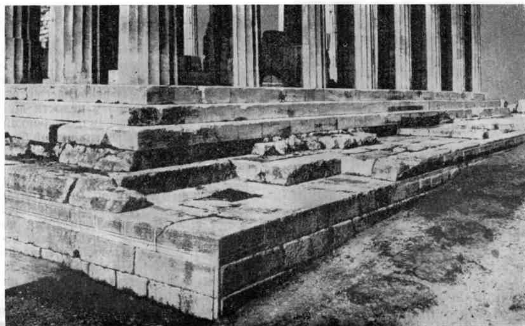
76. Афины. Парфенон. Стереобат (видны криватуры ступеней)
